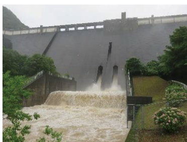
ダム放流状況
