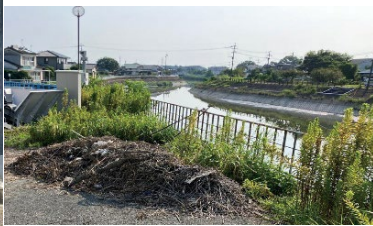
排水機場に流入したゴミ
