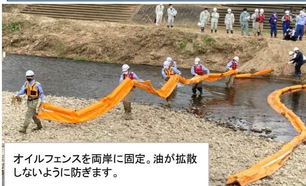
※オイルフェンスとは 水面上に漏れ出した油の拡散防止のため、水面上に設置するフェンスの事です。(写真オレンジ)
