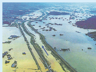
平成2年7月出水後の六角川
