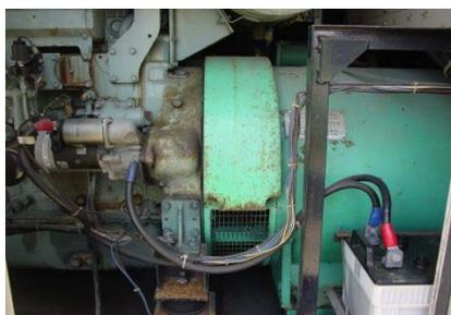
エンジン内部機器腐食状況(既設)
