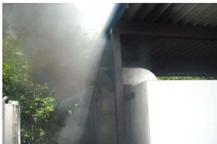
エンジン稼働時排気煙の異常(既設)
