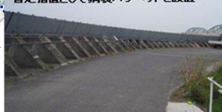
暫定措置として鋼製パラペットを設置
