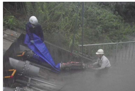
小城市小城町池上 ポンプ設置状況
