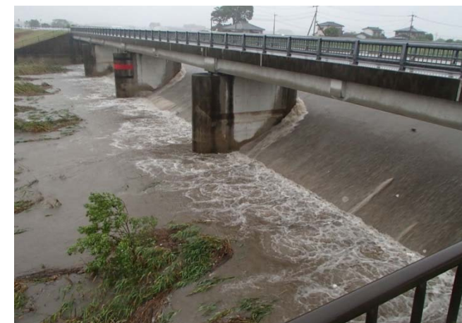
巨勢川調整池（越流堰） 平成30年7月6日 18時11分
