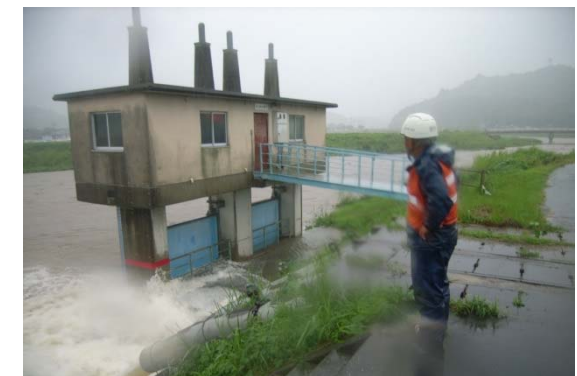
多久市南多久町 庄川排水樋管前 排水状況
