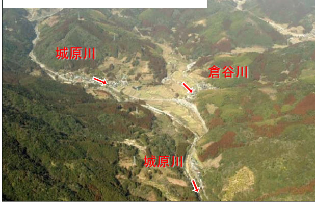
■空から見た城原川ダム予定地
