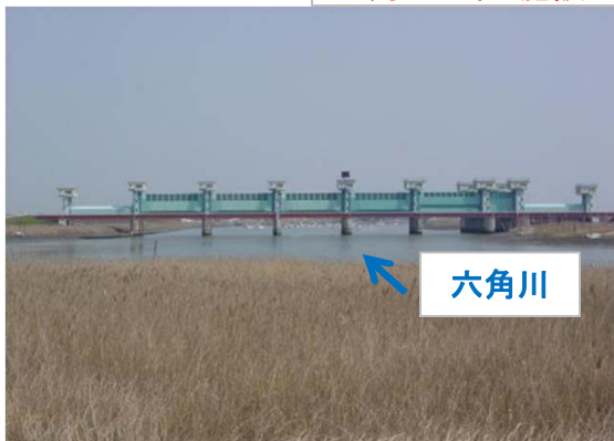
六角河口堰 施設全景
