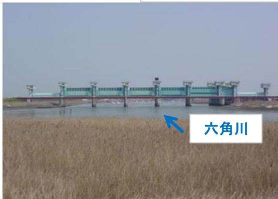
六角河口堰 施設全景
