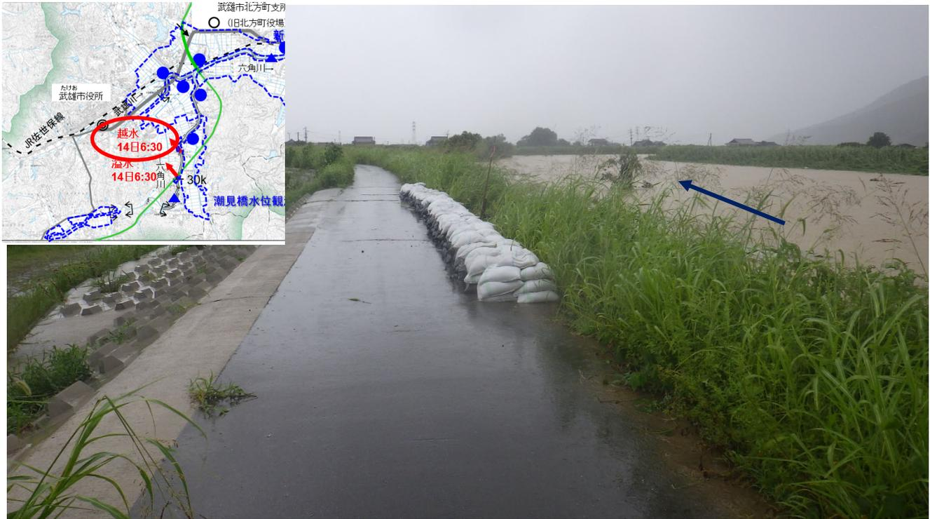
六角川左岸30k400付近 溢水(土嚢積み工 延長約80m)
