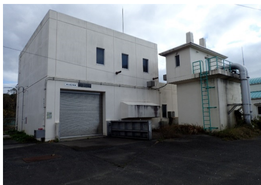
得仏排水機場 施設全景
