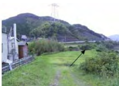
松浦川下流部の無堤区間状況 (唐津市相知町:9/000 左岸付近)
