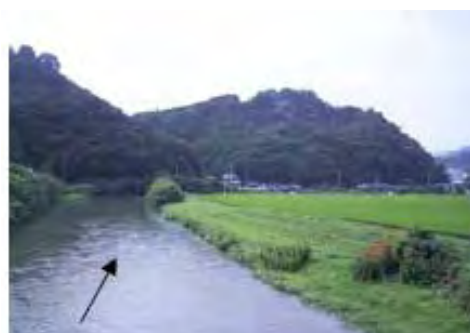
厳木川中流部の無堤区間状況 (唐津市厳木町:6/000 付近)
