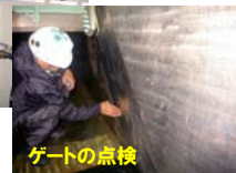
ゲートの点検
