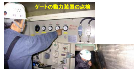
ゲートの動力装置の点検 点検業者： 佐世保重工業(株)
