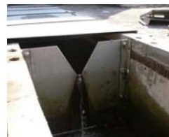
漏水量計（ろうすいりょくけい）
