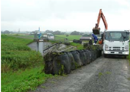
大型土のう設置(白石町)【山崎・近藤地域維持型JV】
