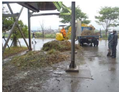
高橋排水機場塵芥処理【富士建設(株)】
