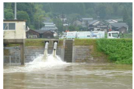
排水ポンプ車運転(武雄市片白)【富士建設(株)】
