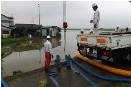
小城市管内の内水排水支援【(株)峰組、(株)石丸建設】
