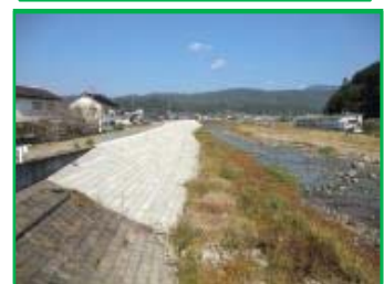
被災箇所の復旧状況
