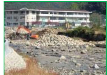
河床掘削が進む現場
