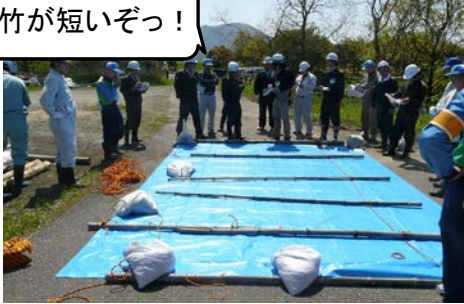
シート張り工
