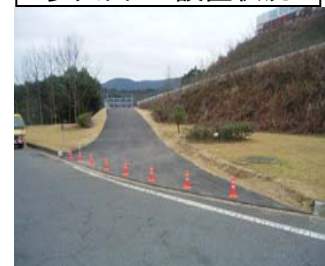
多久西PA設置状況
