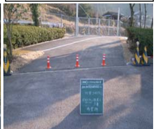
川登SA設置状況
