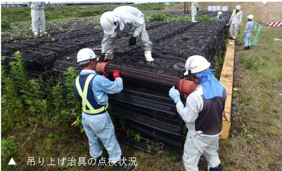
▲ 吊り上げ治具の点検状況
