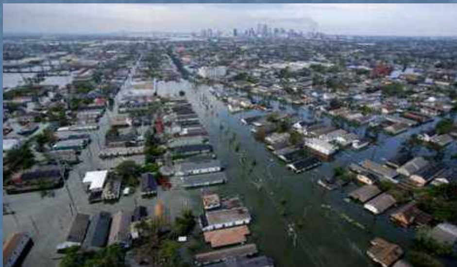
■街全体の浸水状況
