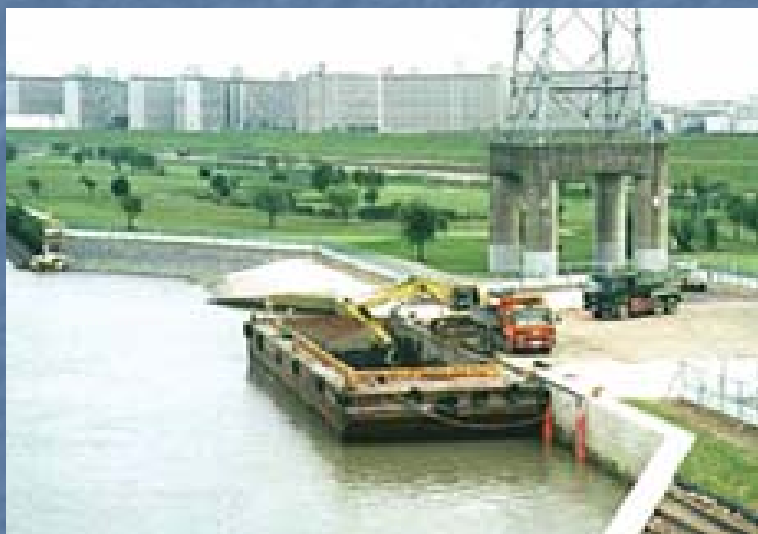
緊急用船着場 緊急用船着場
