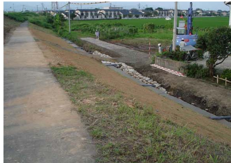
川裏復旧状況
