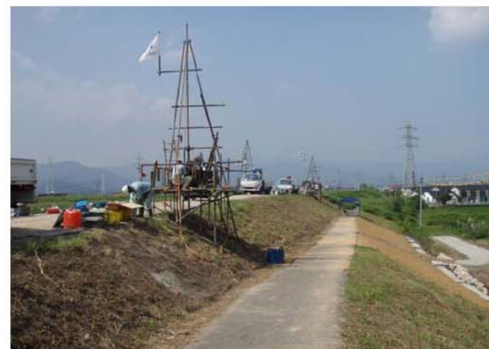
地質調査の実施状況
