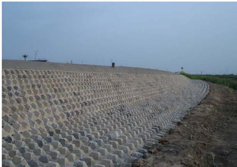
川表復旧状況
