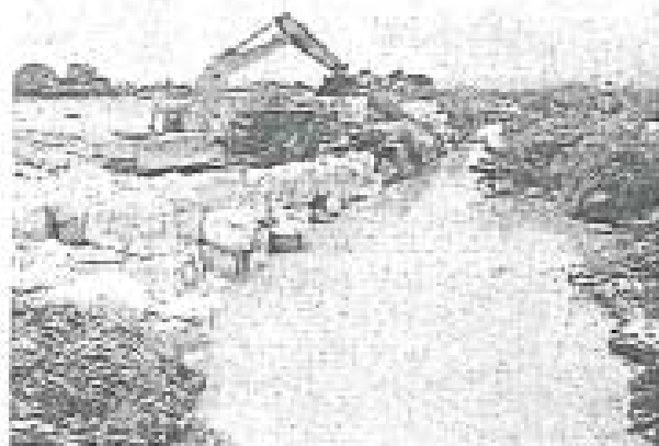
決壊箇所を土のうを積む工事が急ピッチで進められる金立川＝23日午後3時ごろ
