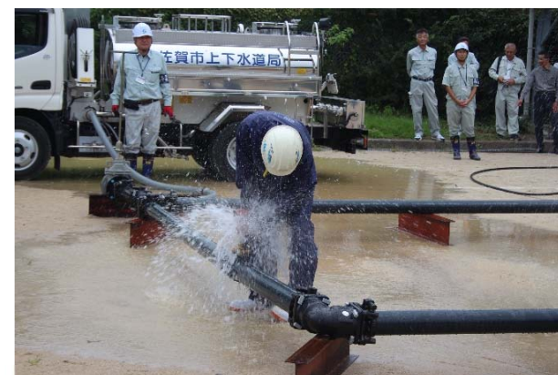
▲ 水道管復旧訓練
