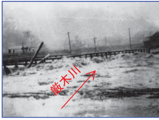
厳木川 厳木橋流出状況
