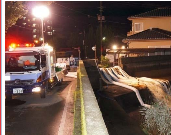
排水ポンプ車による排水
