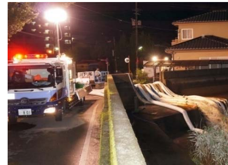
排水ポンプ車を活用した訓練
