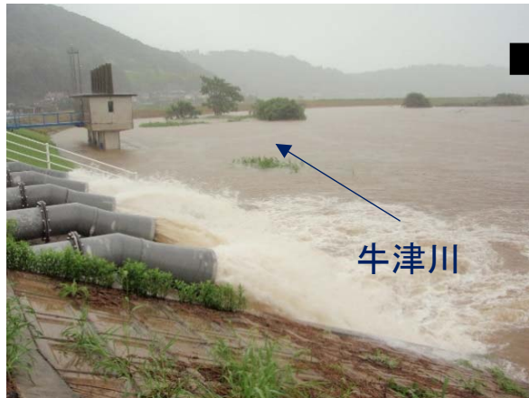
ポンプの運転調整実施時の河川の状況(H21.7.26洪水実績)
