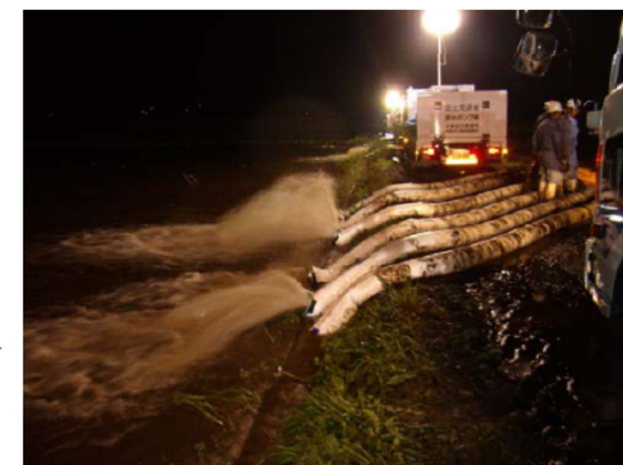
排水ポンプ車による排水
