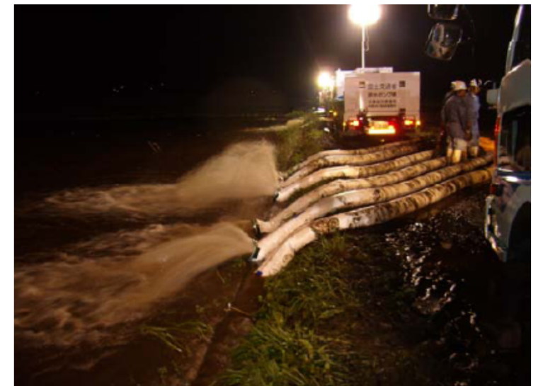
排水ポンプ車による排水
