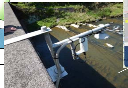
▲危機管理型水位計取付イメージ写真 (超音波式)
