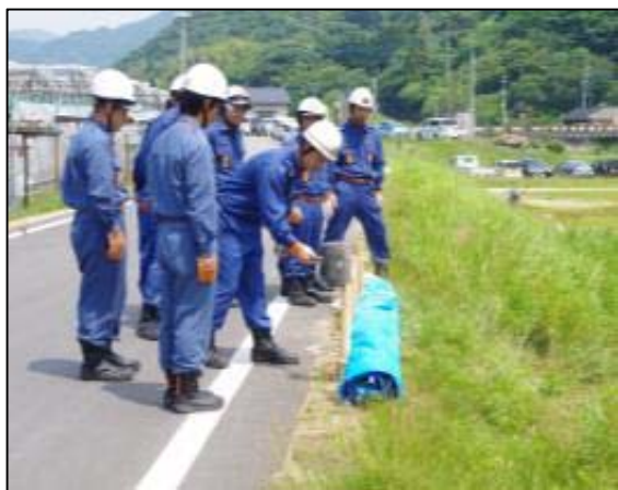
水防マット工
