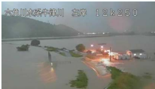
佐賀県多久市内における浸水被害状況
