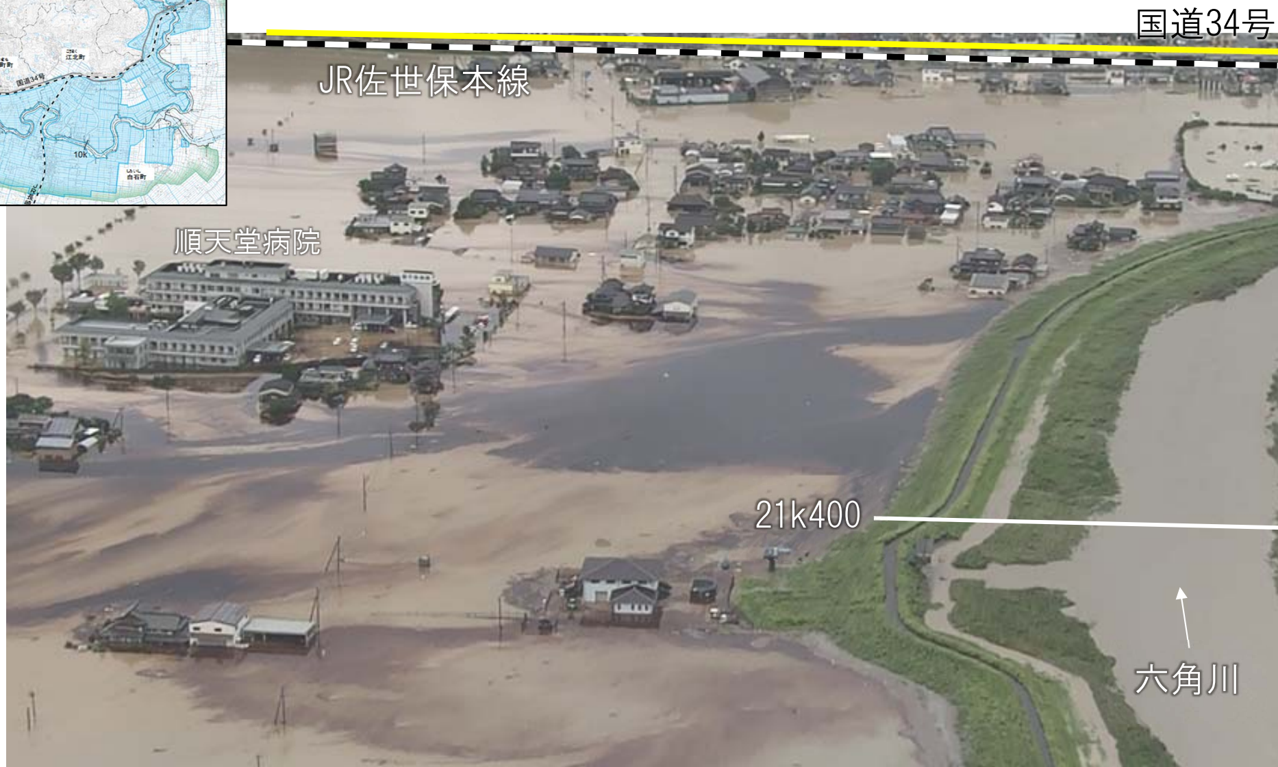
六角川21k付近左岸を望む(令和元年8月28日 15時頃)
