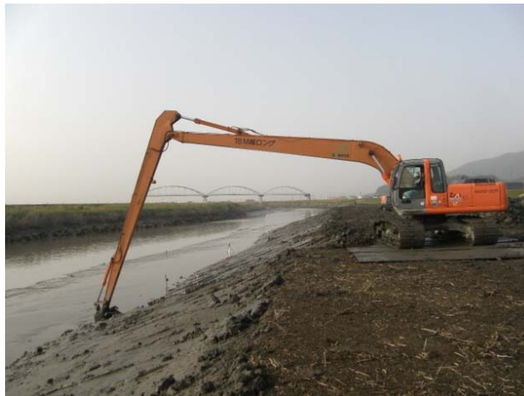
▲ 河道掘削状況
