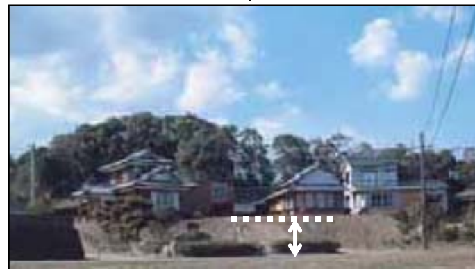
宅地嵩上げの事例（宮崎県：五ヶ瀬川）
