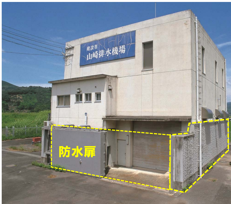
▲ コンクリート等による防水壁設置
