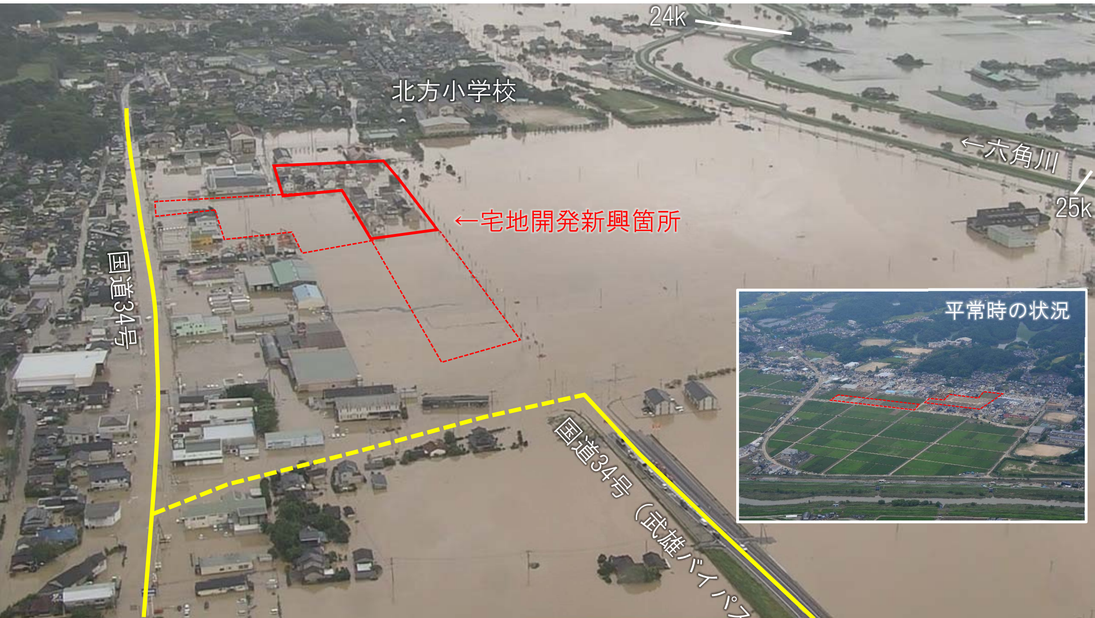
六角川25k付近左岸を望む(令和元年8月28日 15時頃)
