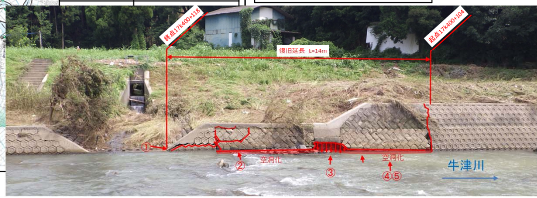
牛津川護岸損壊写真
