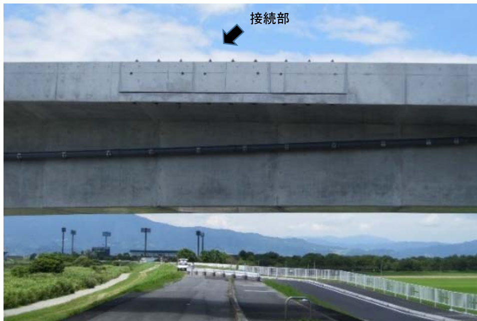
河川堤防と地域高規格道路の接続 ※嘉瀬川：地域高規格道路側の接続箇所整備済
