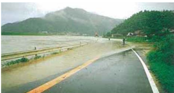
平成 2 年 7 月豪雨 (伊岐佐川合流点付近)
