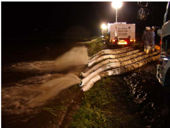
排水ポンプ車による排水
