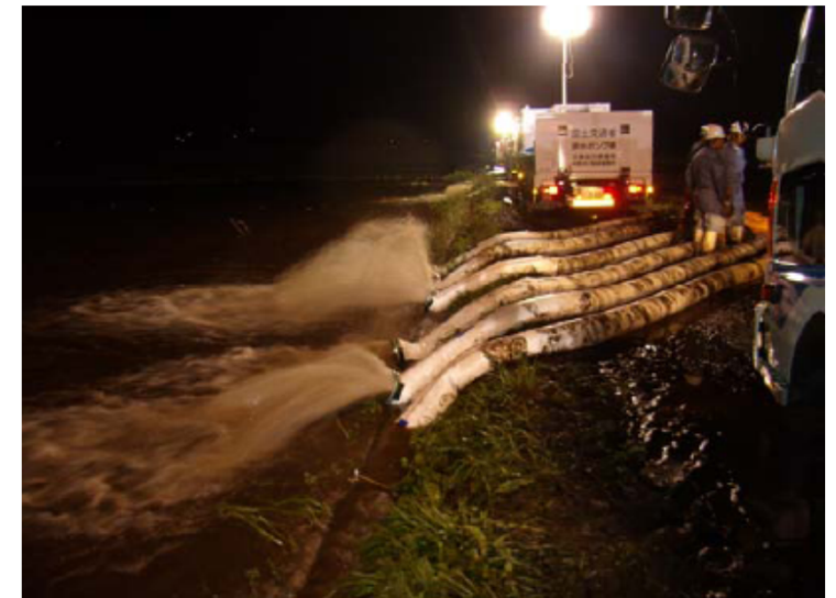
排水ポンプ車による排水
