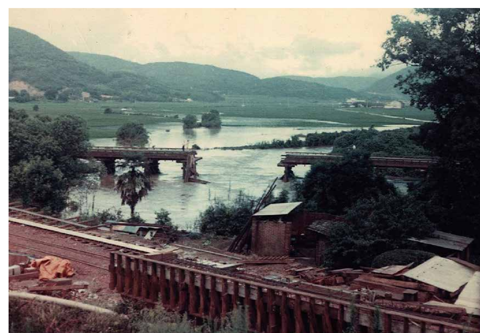
旧大井手橋(奥)と工事中的大井手橋(手前)
