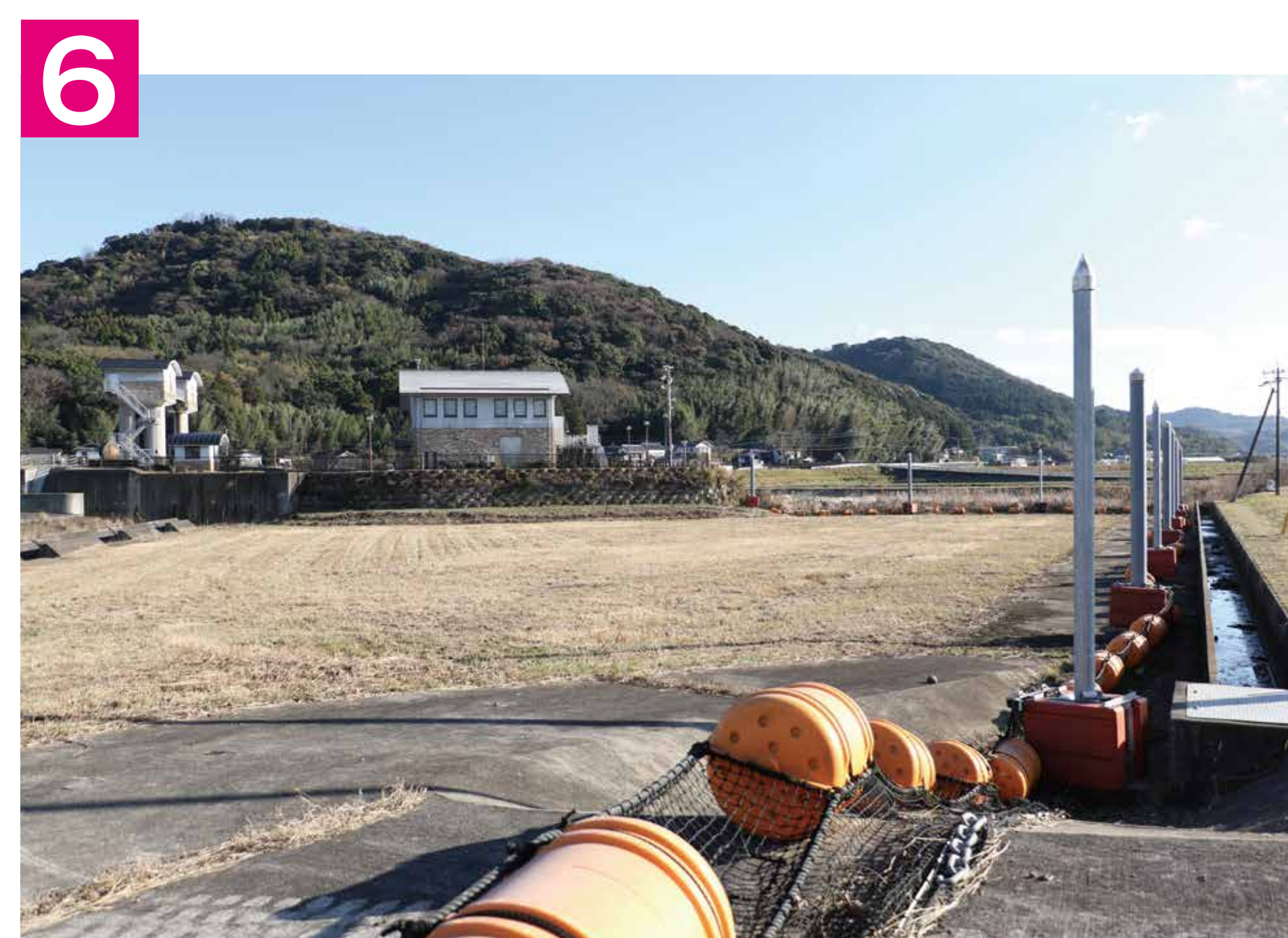
6 網場 あ ば 水位が上がるとボールに沿って網が上昇し、洪水によって流れてくる木やゴミが遊水地内に入ってくるのを防ぎます。
