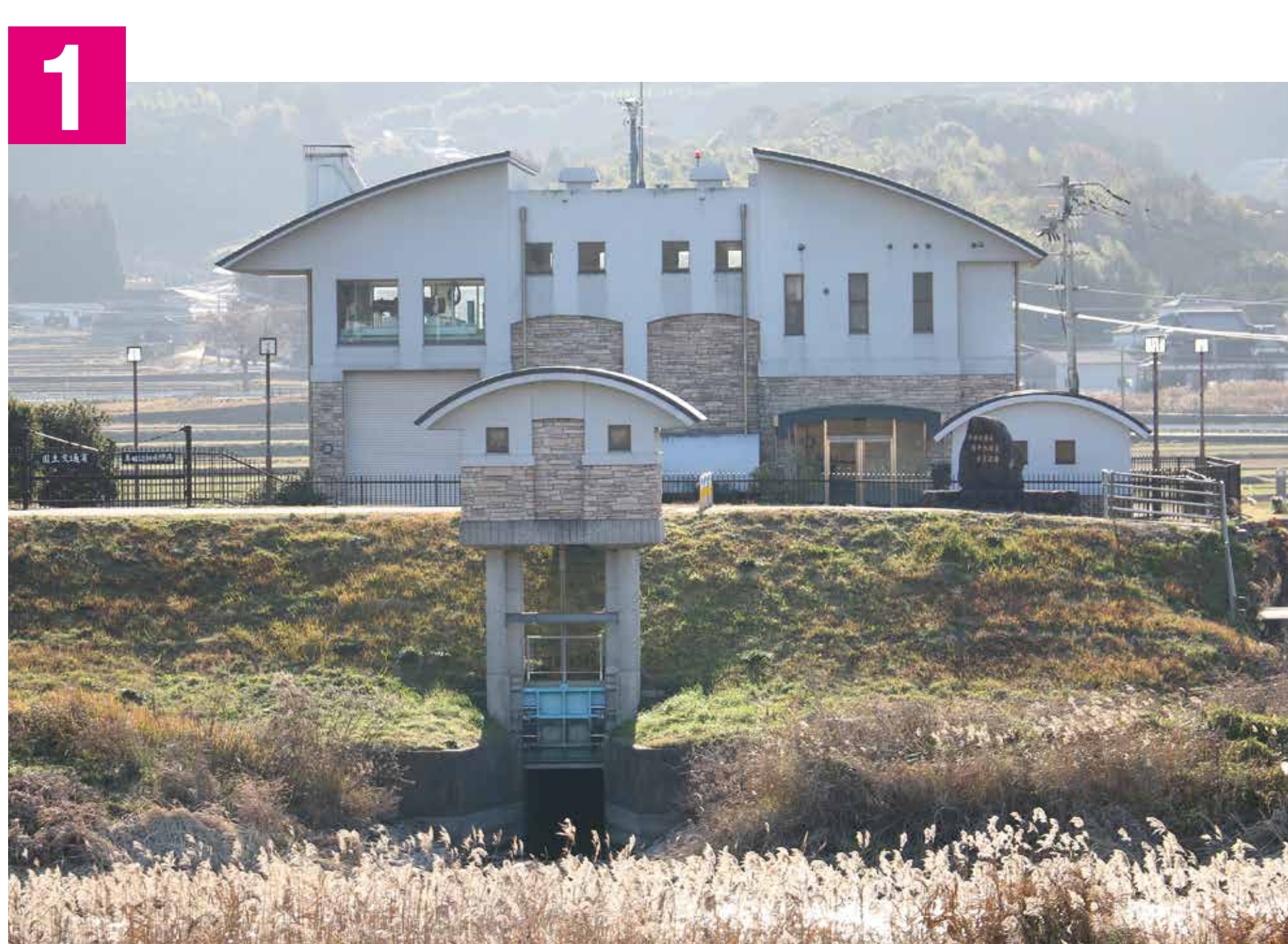
1 排水機場 はい すい き じょう 【排水能力5m 3 /秒】 遊水地内の水を強力なポンプで牛津川に排水します。
