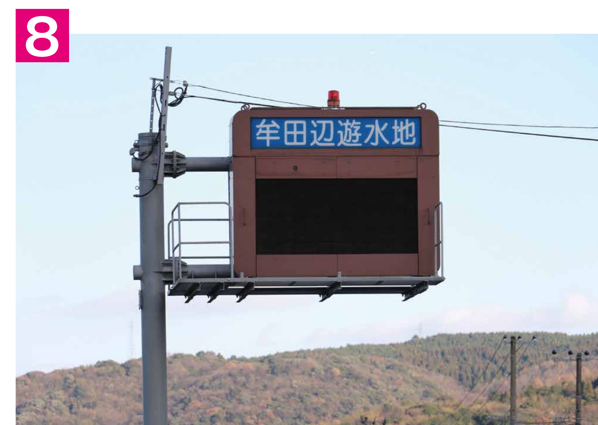
8 情報標示板 じょうほうひょうしばん 大雨の時、川の状況や牟田辺遊水地内の道路の浸水情報等をお知らせします。
