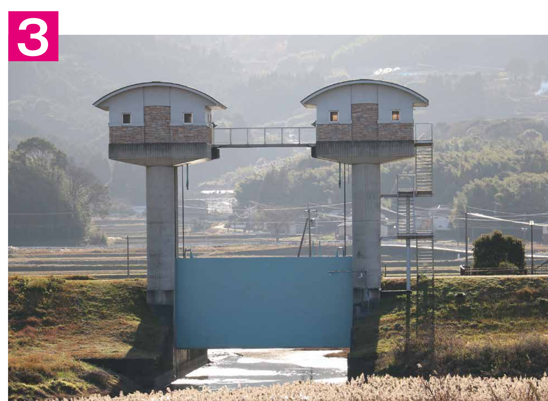
3 水門 すい もん 【水門幅12m】 洪水時には水門を閉めて、牛津川の水が遊水地内に逆流するのを防ぎます。
