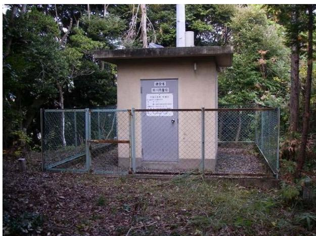
写真 5.2.1 流域内の雨量観測（雨量観測所）
