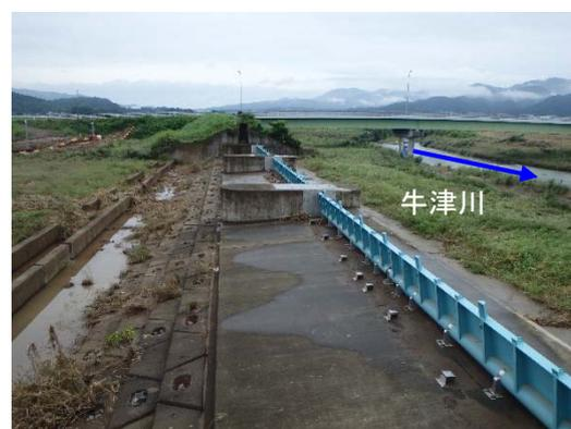
写真 1.2.25 牟田辺遊水地越流堤の可動化状況
