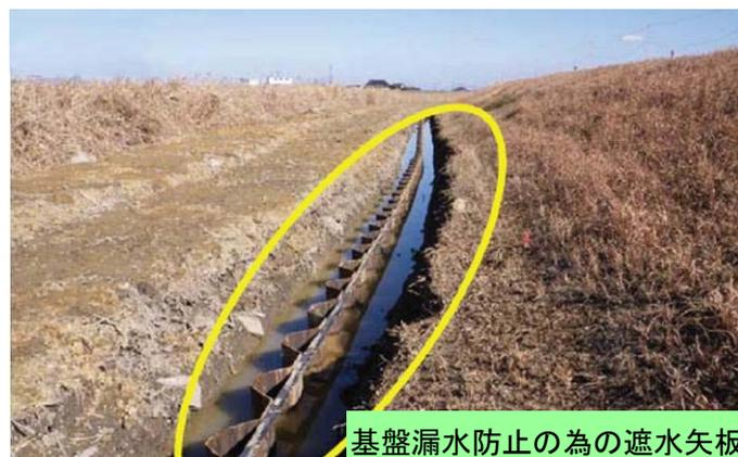
写真 2.1.3 堤防基盤漏水への対策事例
