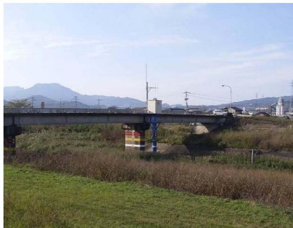
写真 5.2.2 河川の水位観測（水位観測所）
