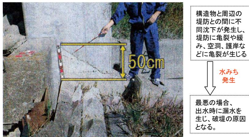
図 2.1.8 排水樋管周辺の地盤沈下
