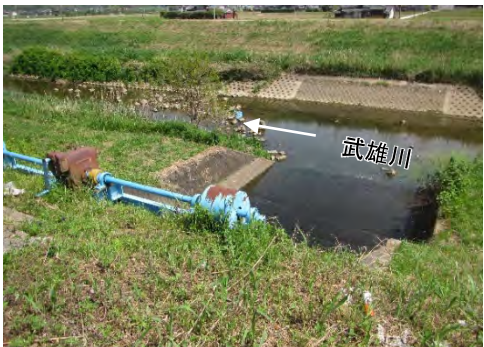
下水道の排水先の状況 (富岡雨水幹線)
