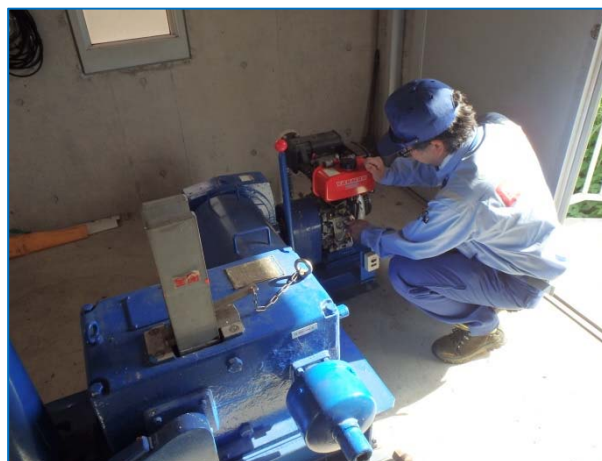
納手分水樋管 開閉装置調査 (武雄市)
