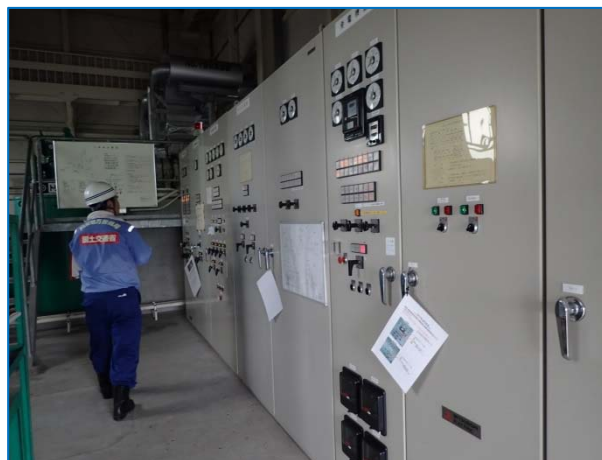
三条排水機場 操作盤調査 (芦刈町)
