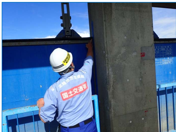
満神排水樋管 扉体調査 (小城市)
