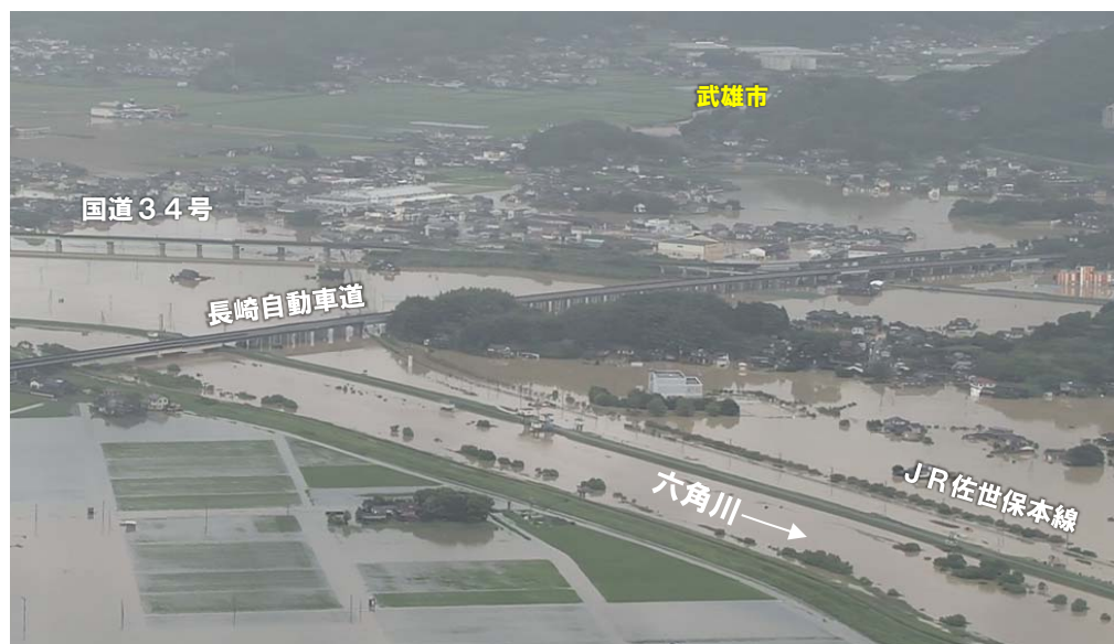
六角川25k付近左岸を望む
