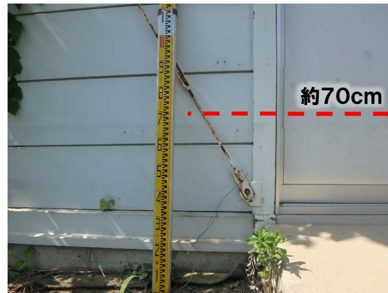
水防倉庫、排水ポンプ車格納庫付近
