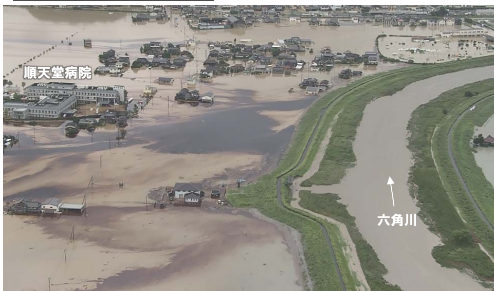
六角川21k付近左岸を望む
