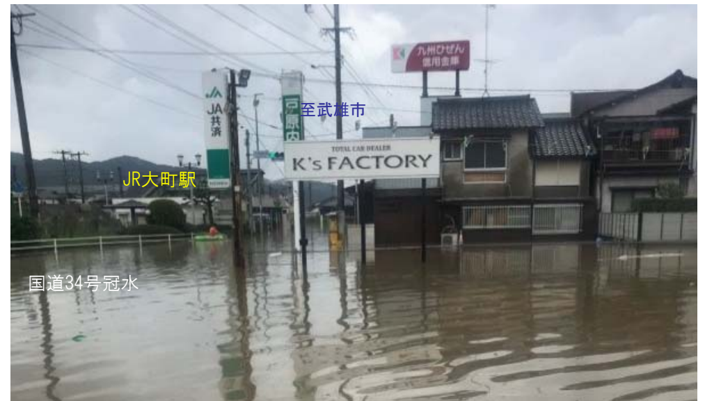
六角川左岸19.4k付近 浸水状況(JR大町駅付近)
