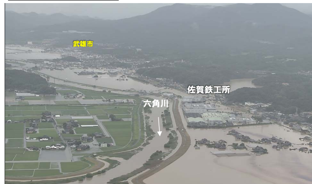
六角川22k付近左岸を望む
