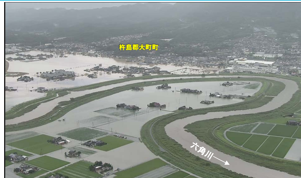
六角川19k付近左岸を望む
