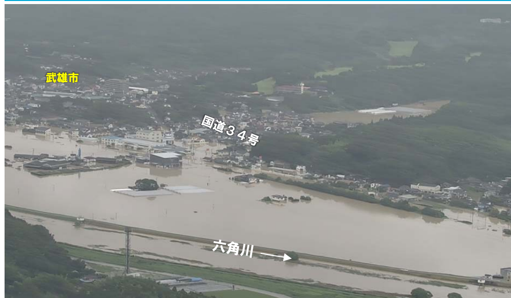
六角川23k付近左岸を望む
