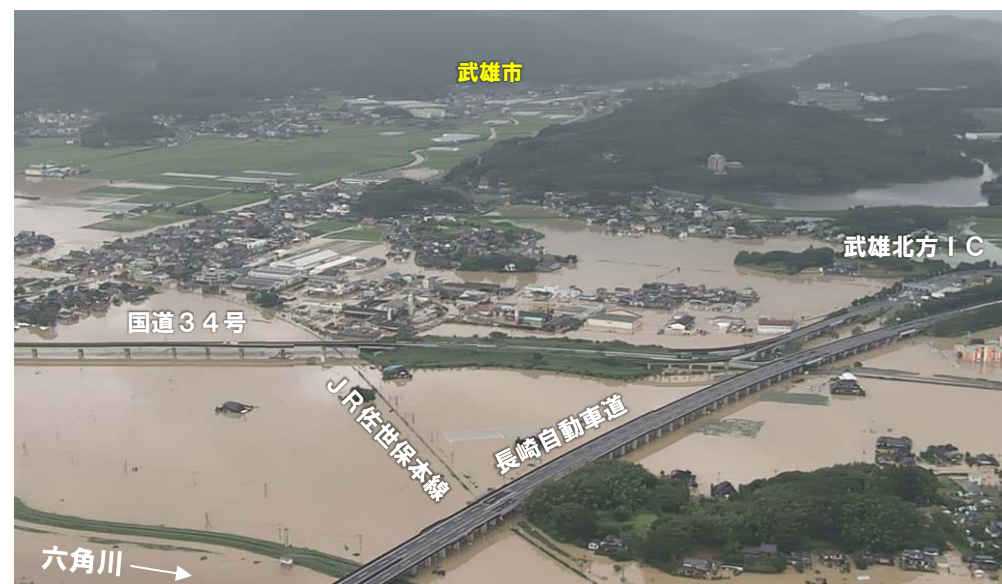
六角川26k付近左岸(武雄北方IC付近)を望む
