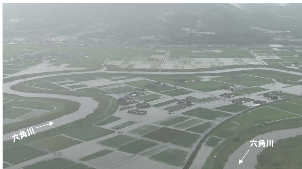
六角川14k付近右岸(蛇行部)を望む
