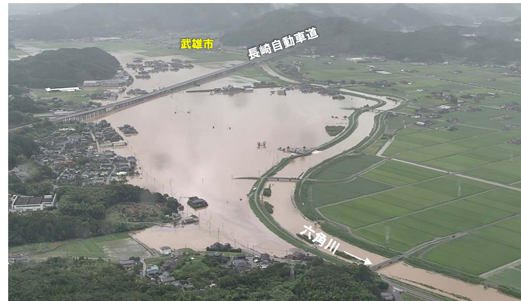
六角川28k右岸付近を望む
