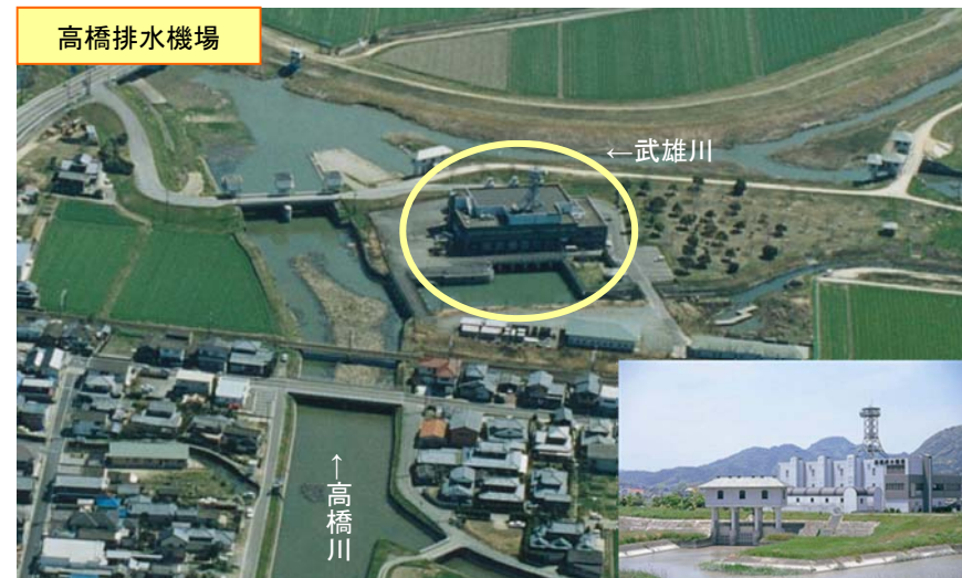
高橋排水機場 ポンプ規模: 50m 3 /S
