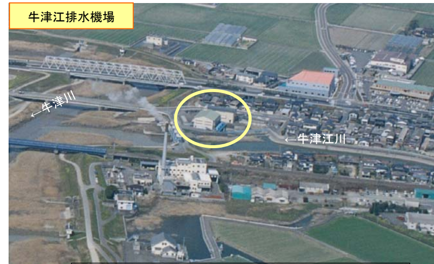
牛津江排水機場 ポンプ規模: 50m 3 /S
