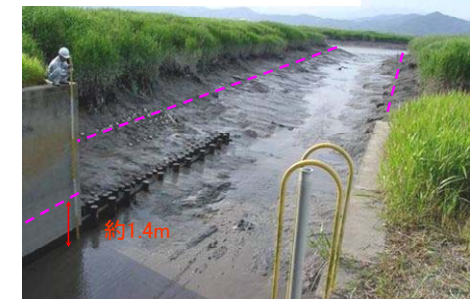
ガタ土除去後の状況
