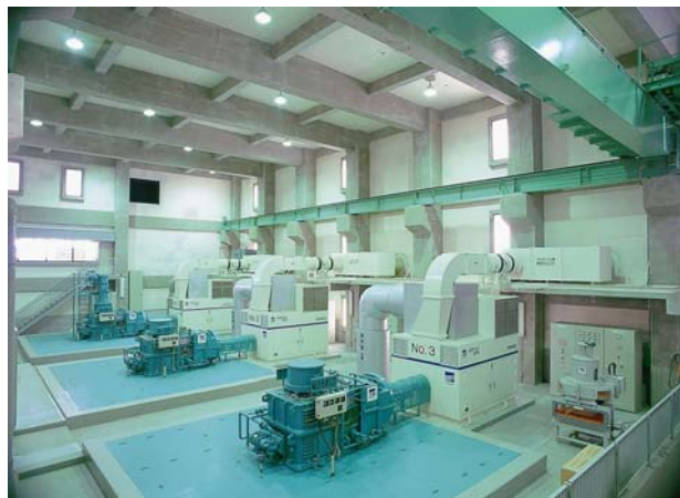
写真 高橋排水ポンプ場
