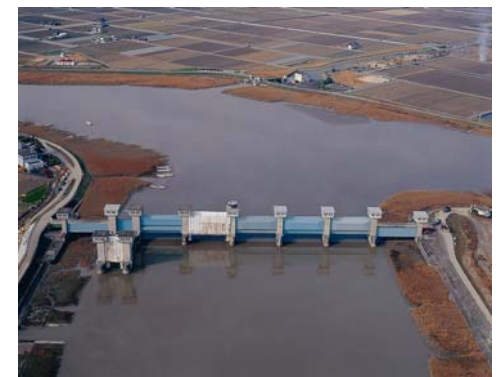
写真 六角川河口堰の状況
