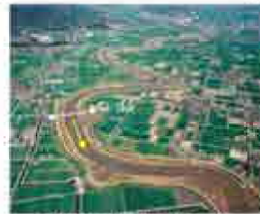
写真 1.1.8 牛津川下流部 (3.0km 付近)
