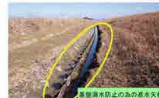
写真2.1.3 堤防基盤漏水への対策事例
