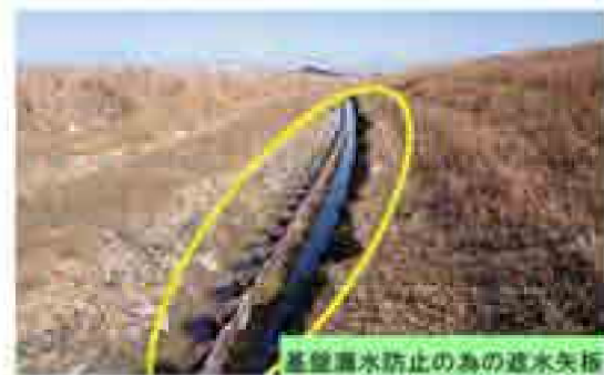
写真2.1.3 堤防基盤漏水への対策事例
