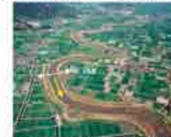
写真 1.1.8 牛津川下流部 (3.0km 付近)
