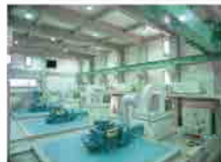
写真4.2.1 高橋排水ポンプ場
