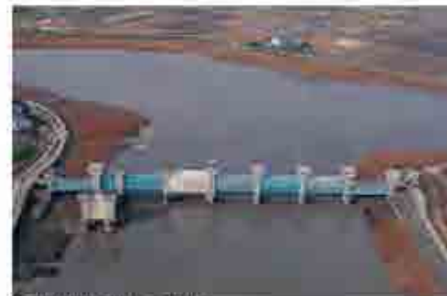
○六角川河口堰の状況
