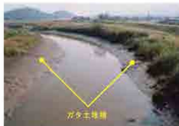
○ガタ土堆積状況
