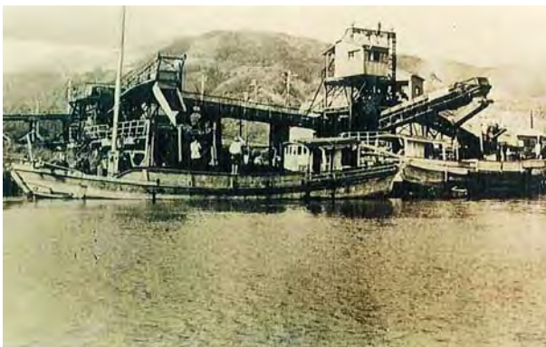
写真 1.1.13 ベルトコンベアによる石炭の船積 (出典:フォト・グラフ武雄 30)
