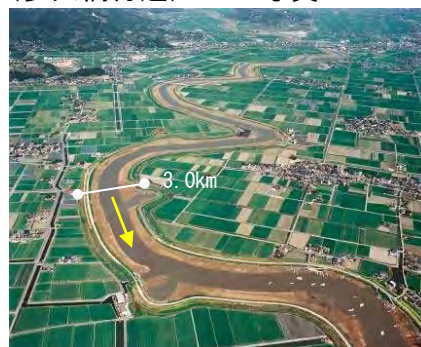
写真 1.1.8 牛津川下流部（3.0km 付近）
