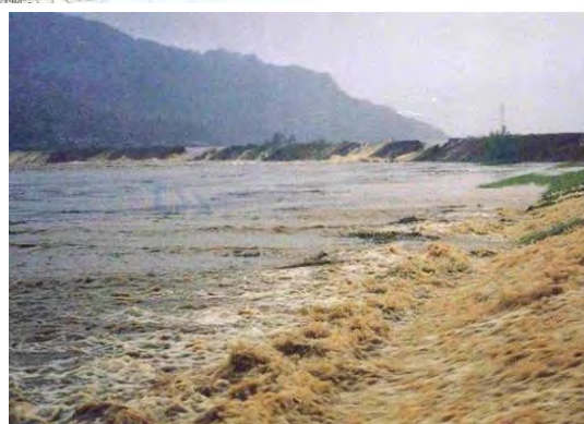
④ 多久市東多久町での堤防からの越水状況（納所地区） のうも
