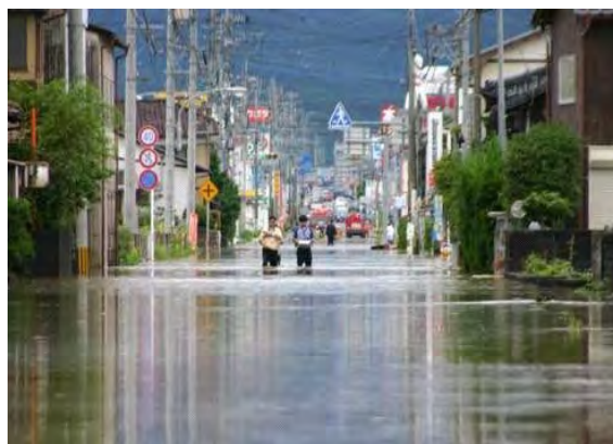
写真 1.2.9 武雄市高橋地区での内水被害
