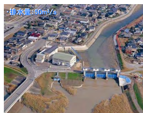
写真 1.2.19 牛津江排水ポンプ場 (平成13年3月 第2排水ポンプ場完成)
