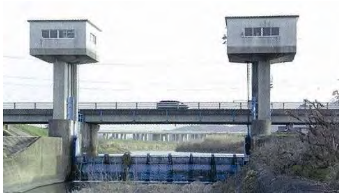
写真 1.2.15 大日堰 (昭和 57 年 3 月完成)
