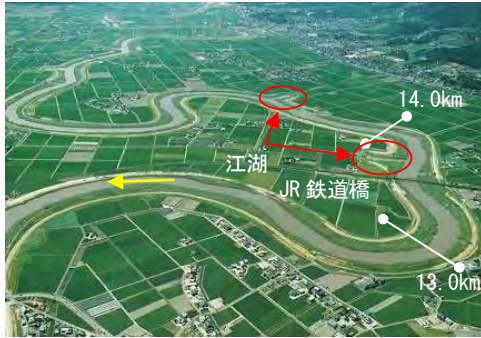
写真 1.1.4 六角川下流部（JR 鉄道橋付近）
