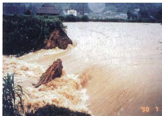
② 武雄市橋町での堤防の決壊状況（永島地区）
