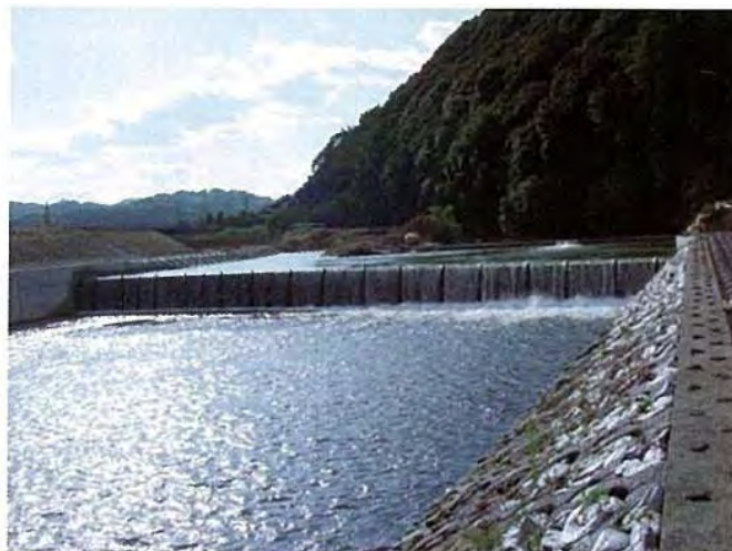
写真 1.2.17 大井手堰 (平成 17 年 1 月完成)
