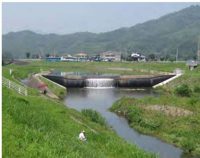
写真 1.2.16 小井手堰 (平成 17 年 3 月完成)
