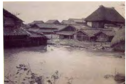
写真 1.2.2 小城市牛津町での浸水状況 〔昭和31年8月〕
