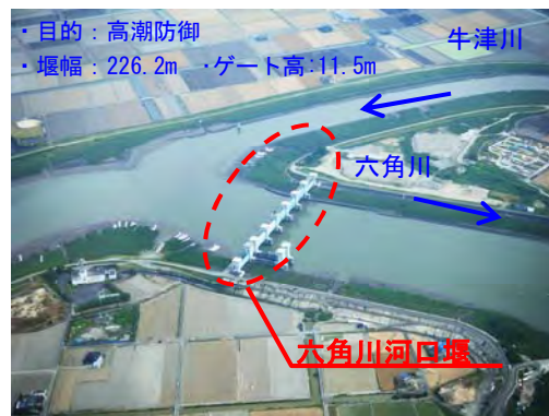
写真 1.2.21 六角川河口堰(昭和 58 年 3 月完成)
