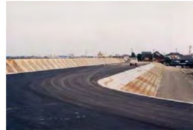
写真 1.2.20 高潮堤防の整備
