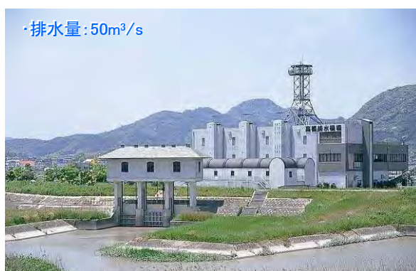
写真 1.2.18 高橋排水ポンプ場 (平成9年3月完成)
