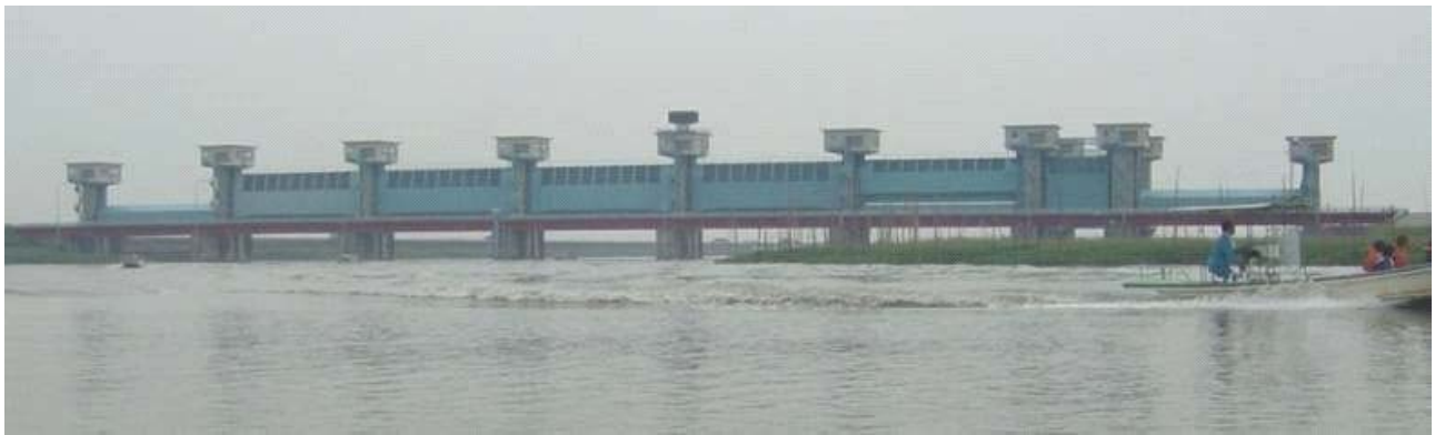
写真 2.1.6 六角川河口堰（昭和58年完成）
