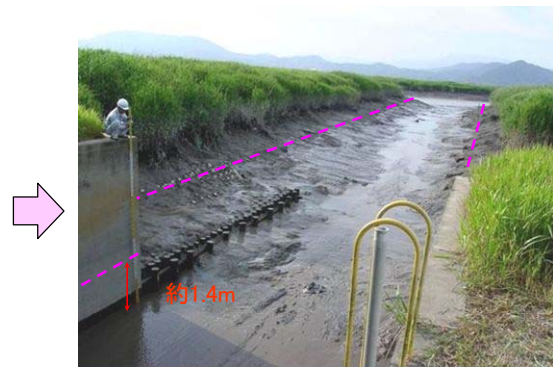
写真 2.1.11 ガタ土除去後の状況
