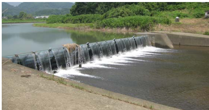
写真 2.3.48 鱒ノ瀬堰（牛津川 17.1km 付近）
