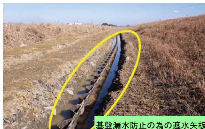
写真2.1.3 堤防基盤漏水への対策事例
