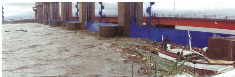
写真 2.1.7 昭和60年台風13号での高潮防御状況
