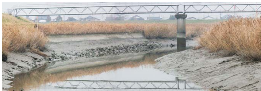
写真 2.1.2 河道に堆積するガタ土
