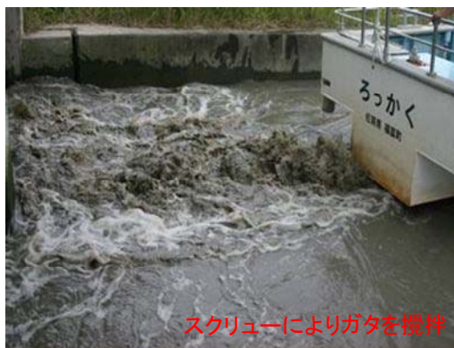
写真 2.1.12 ガタ土除去船によるガタ土除去状況
