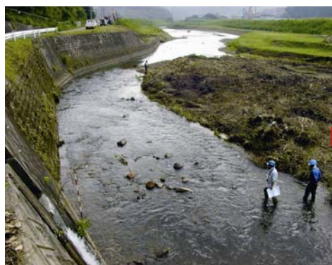
写真 2.3.31 覆土前のコンクリート低水護岸
