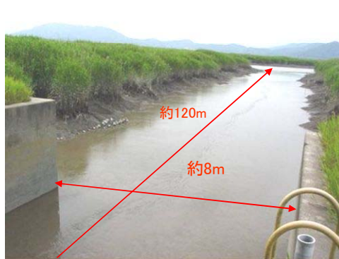
写真 2.1.10 樋管前面水路のガタ土堆積状況
