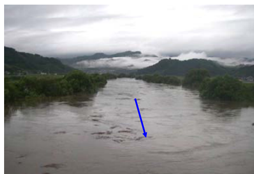
写真 2.1.9 牛津川中流部河道内樹木繁茂状況
