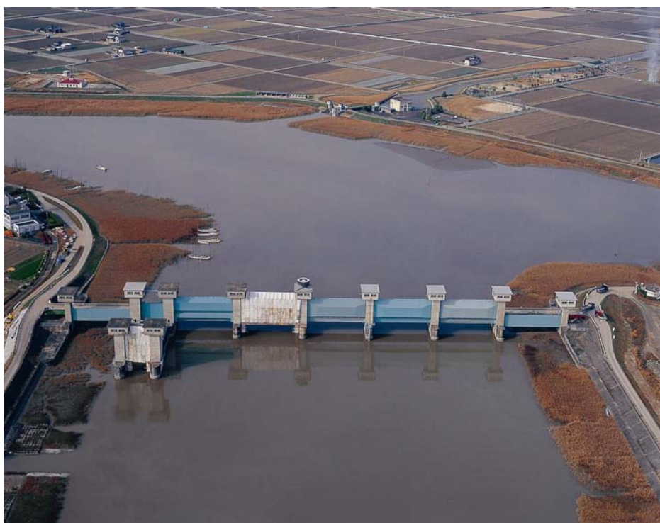
写真4.3.4 六角川河口堰の状況
