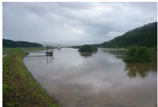
写真4.3.2 河道内樹木による流下障害
