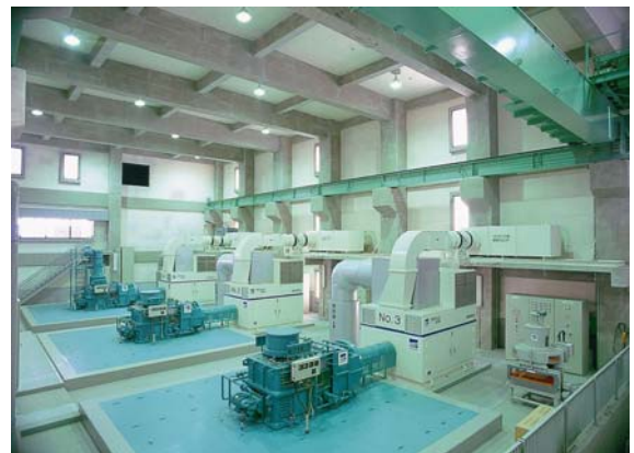
写真4.2.1 高橋排水ポンプ場
