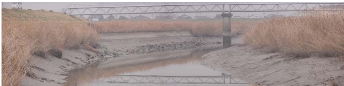
写真4.3.3 河道に堆積するガタ土
