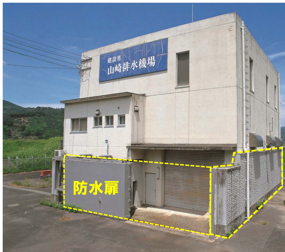
▲ コンクリート等による防水壁設置
