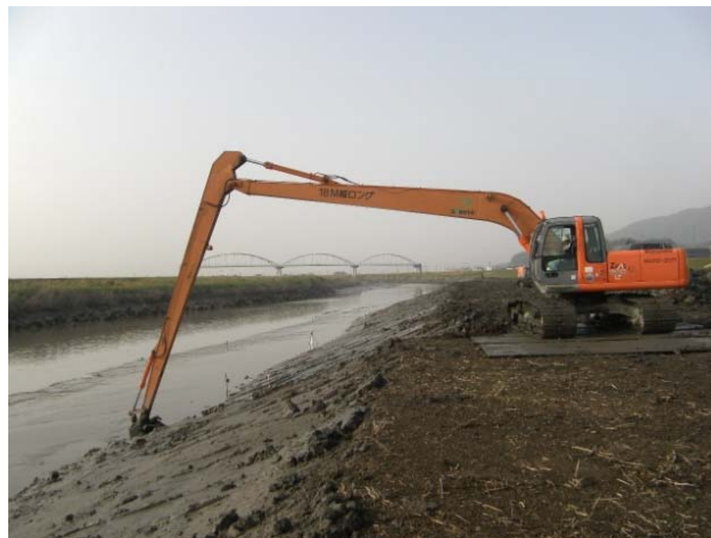
▲ 河道掘削状況
