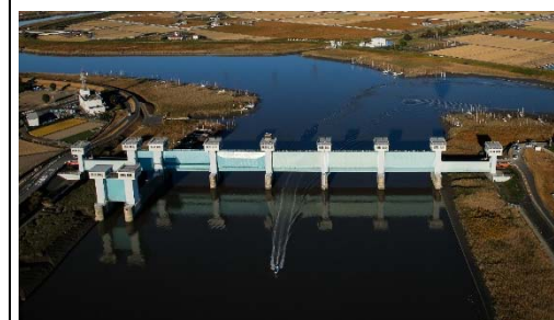
六角川河口堰の状況
