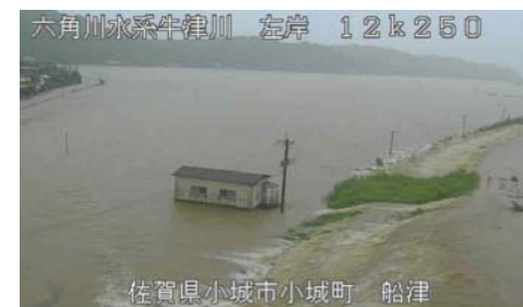
六角川水系牛津川における堤防越水状況
