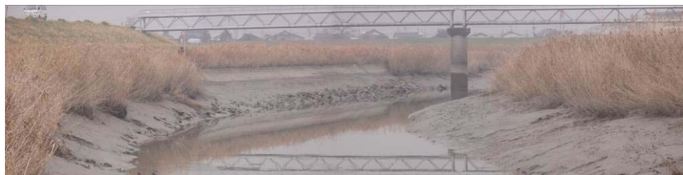
河道に堆積するガタ土
