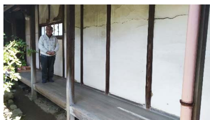
▲個人宅の壁に残る昭和28年の大水害の時の水位跡。地面からの高さは約2m（唐津市）
