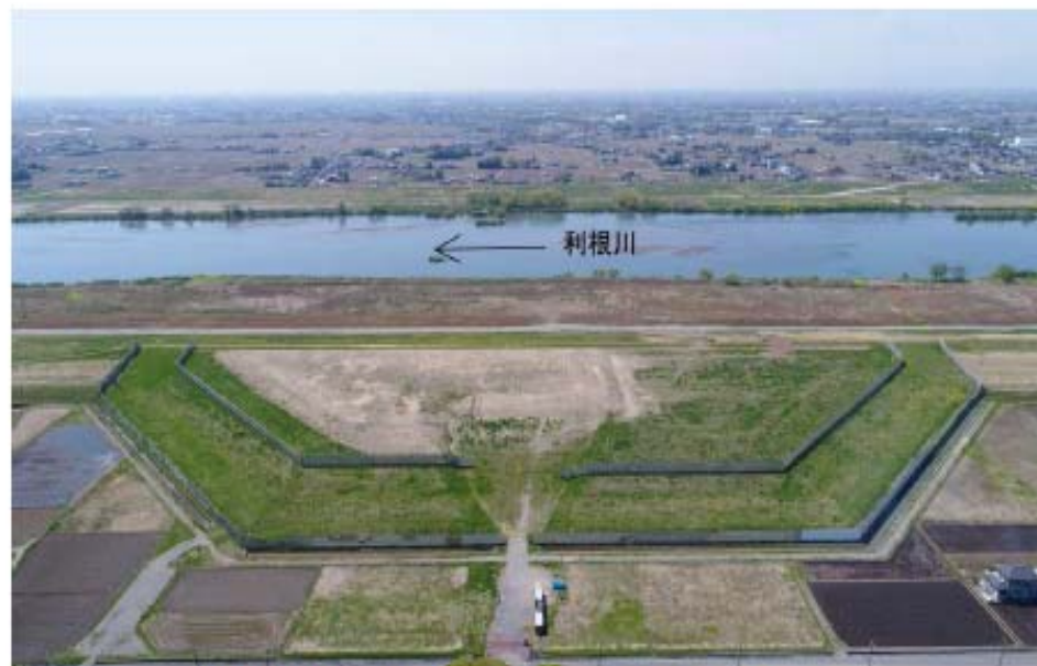
栄地区広域避難地(埼玉県加須市)
