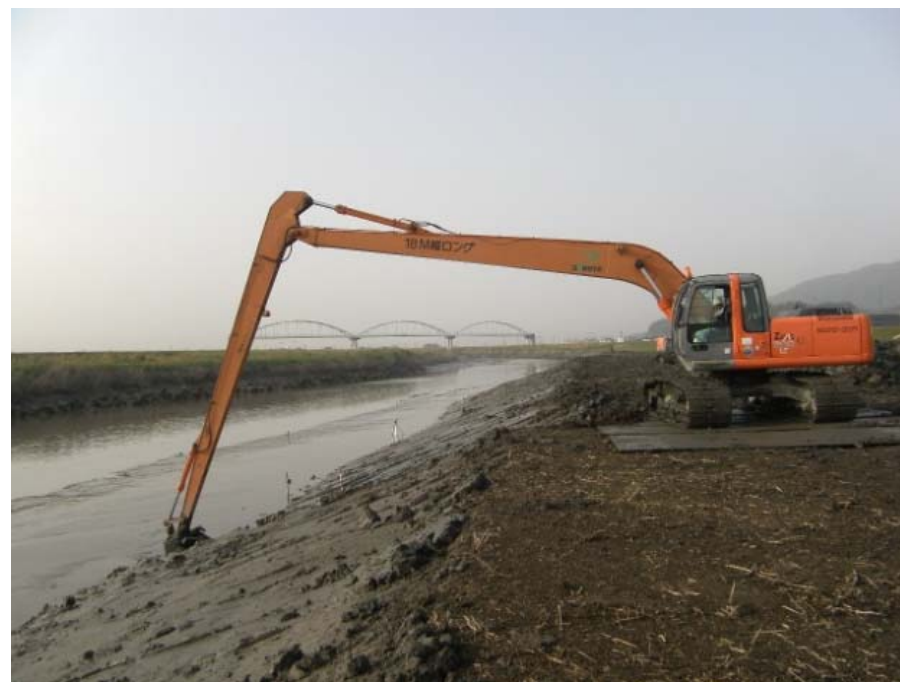
▲ 河道掘削状況
