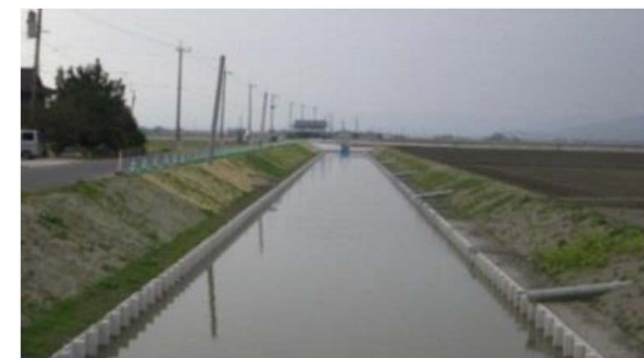
流域内の水路状況（白石町）
