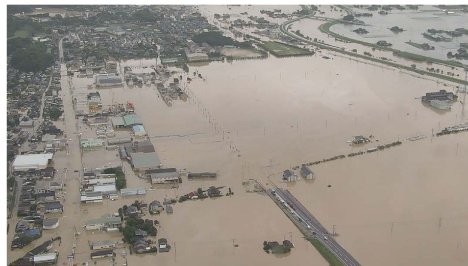
R1年8月洪水時の浸水状況
