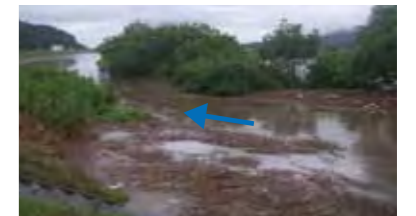
● 河道内樹木による流下阻害状況
