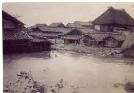
写真 1.2.2 小城市牛津町での浸水状況 〔昭和 31 年 8 月〕
