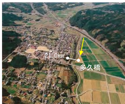
写真 1.1.6 牛津川上流部（多久橋付近）
