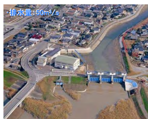
写真 1.2.19 牛津江排水ポンプ場 (平成 13 年 3 月 第 2 排水ポンプ場完成)
