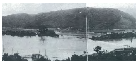
写真 1.2.3 多久市東多久町での浸水状況 （皆木・別府地先）〔昭和 42 年 7 月〕
