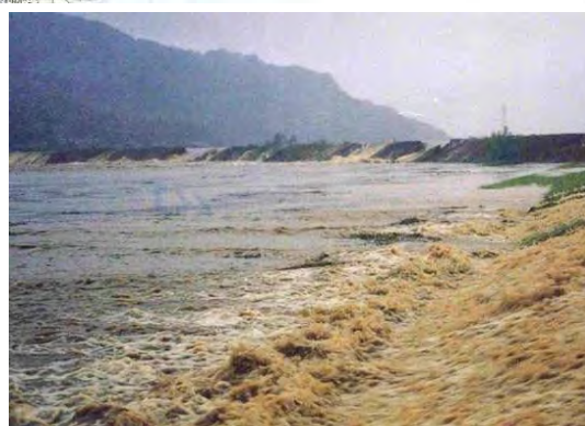
④ 多久市東多久町での堤防からの越水状況（納所地区） のうそ
