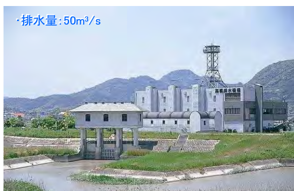
写真 1.2.18 高橋排水ポンプ場 (平成 9 年 3 月完成)
