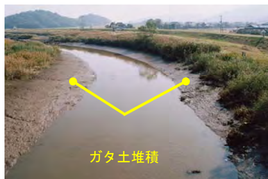
写真 1.1.1 ガタ土堆積状況
