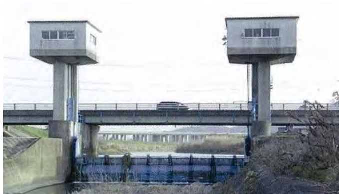
写真 1.2.15 大日堰 (昭和 57 年 3 月完成)
