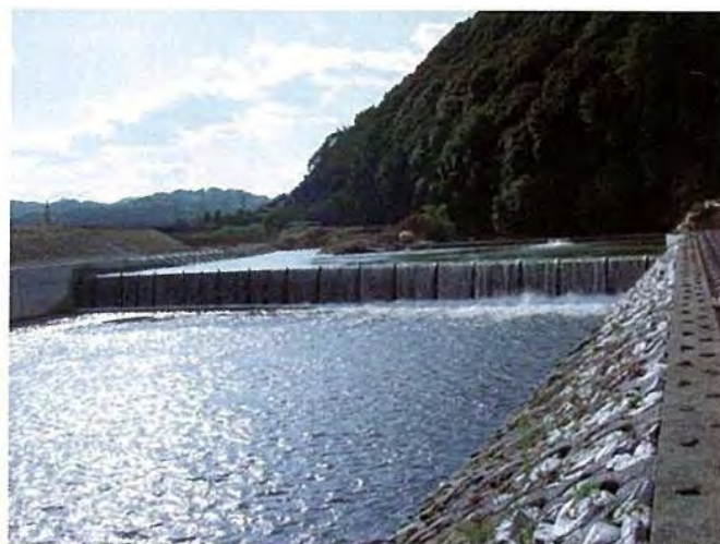
写真 1.2.17 大井手堰 (平成 17 年 1 月完成)
