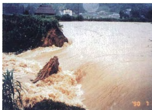
② 武雄市橘町での堤防の決壊状況（永島地区）
