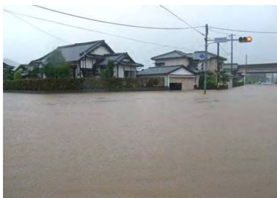
写真 1.2.10 武雄市片白地区での内水被害
