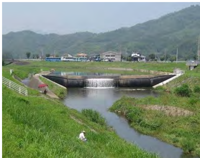
写真 1.2.16 小井手堰 (平成 17 年 3 月完成)
