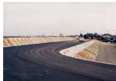
写真 1.2.20 高潮堤防の整備
